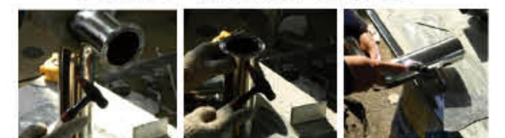
图5.2.4 焊口组对、点焊固定
